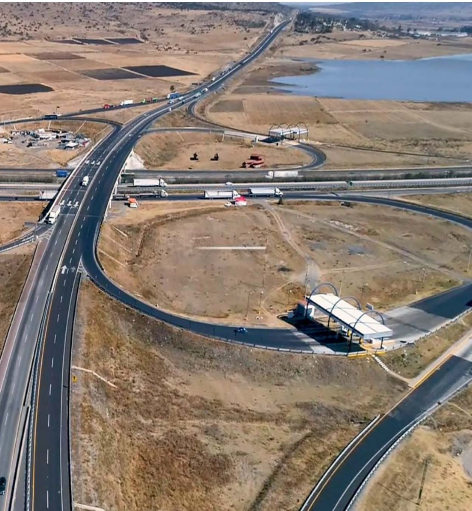
Compromiso de Gobierno– 176. Segundo cuerpo del Arco Norte, tramo Jilotepec–Atacomulco, Estado de México.
