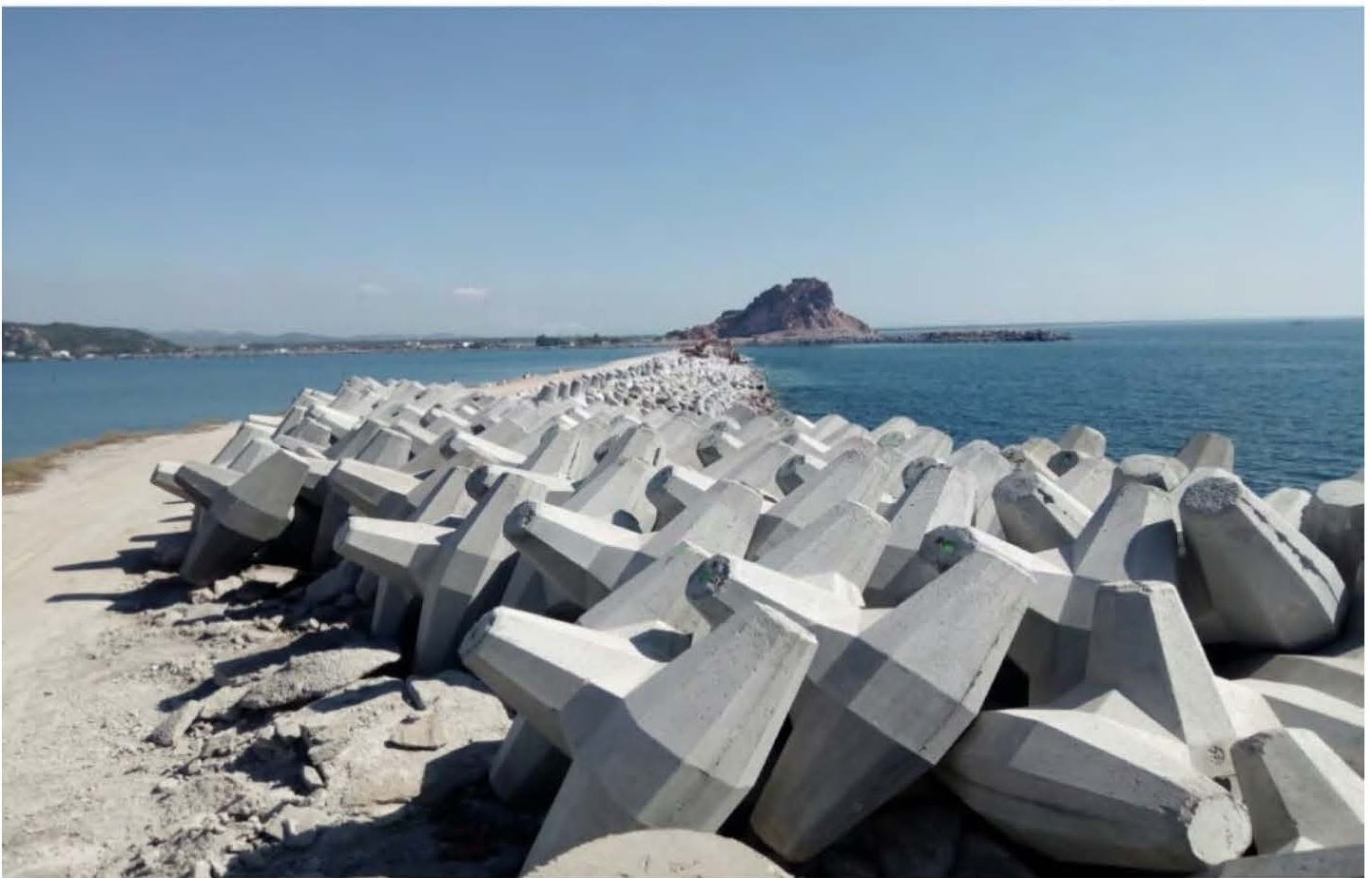
Puerto de Mazatlán, Sinaloa. Durante el segundo semestre del año 2017 se concluyó la rehabilitación en la escollera.
