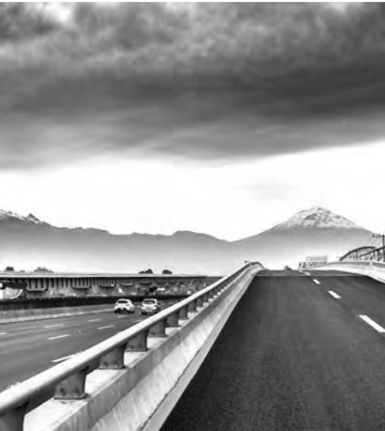
Ampliación de la autopista México-Puebla.
