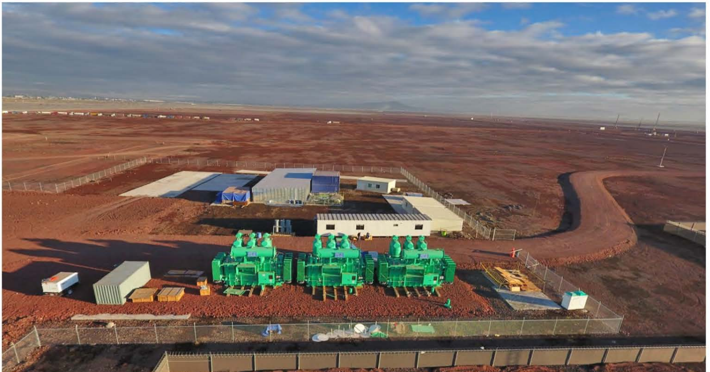
Subestación eléctrica, NAIM. En el segundo semestre del año 2017 se avanza en la construcción del edificio terminal, la subestación eléctrica y la losa del centro de transporte terrestre.
