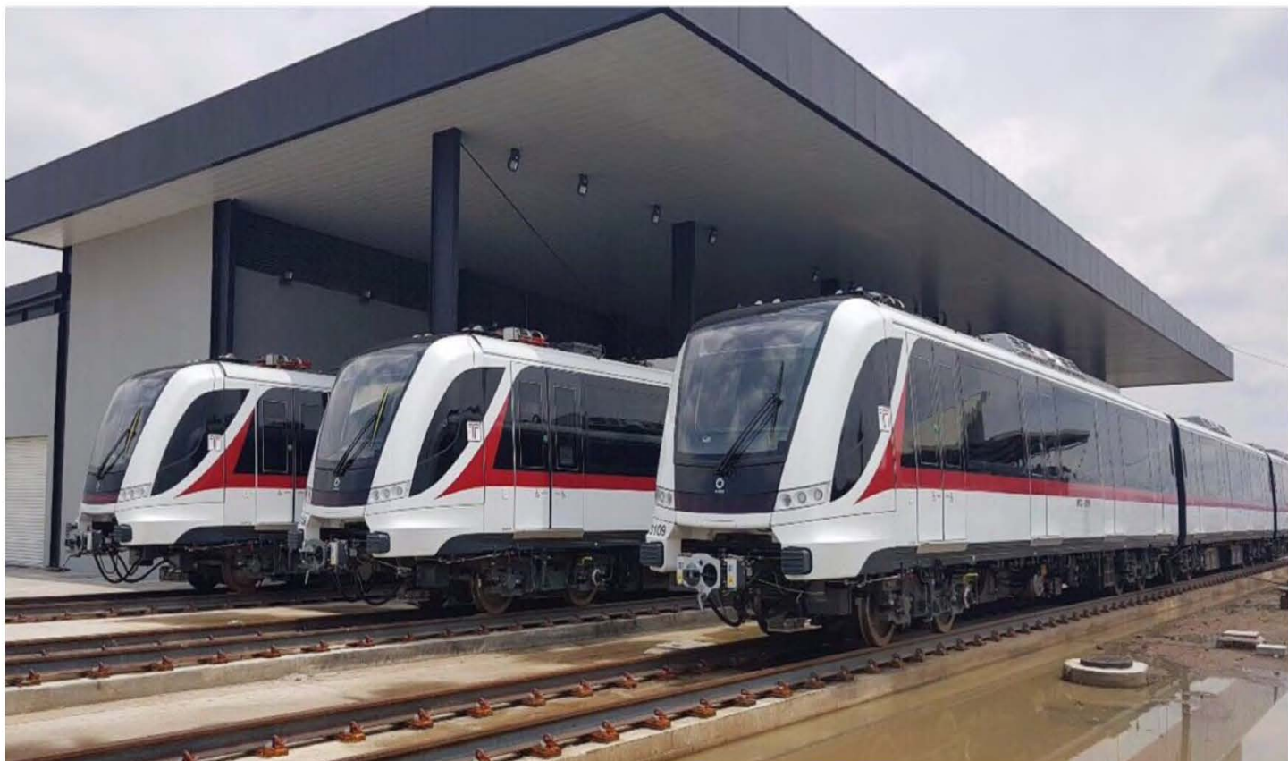
Durante el segundo semestre de 2017, se recibieron 9 trenes con tres vagones cada uno con lo cual se concluyó la entrega de los 18 trenes que integran el Tren Ligero Guadalajara.
