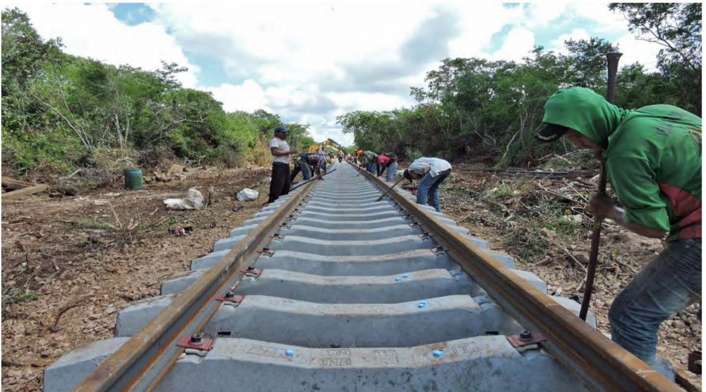
Rehabilitación de las vías del Tren Chiapas—Mayab.
