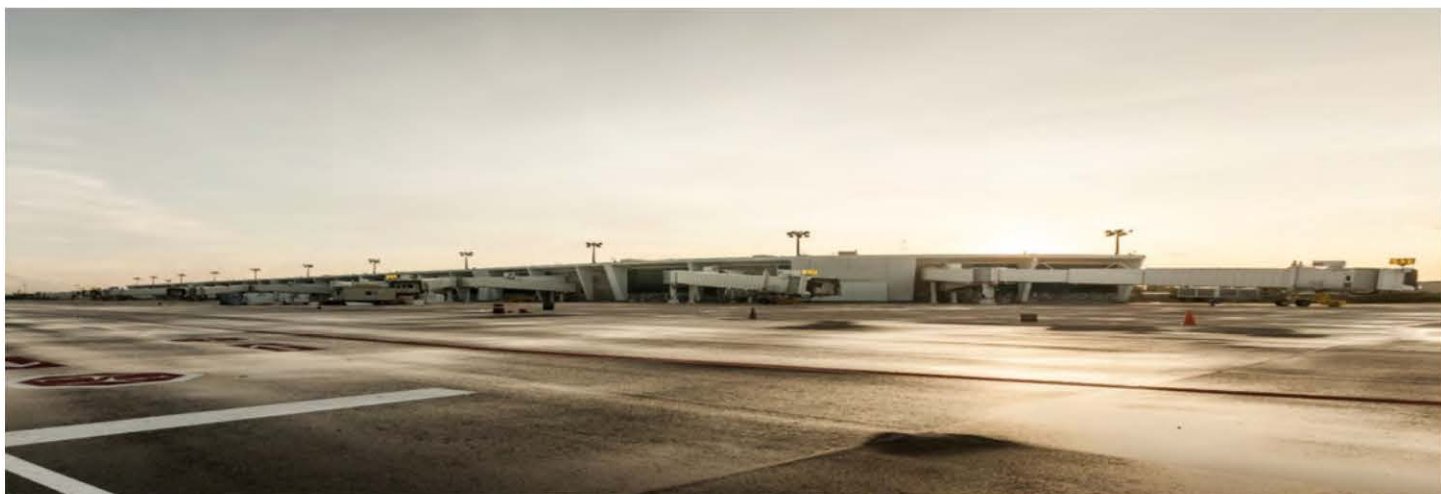
Ampliación de la Terminal 4, Aeropuerto de Cancún, Quintana Roo, con capacidad para atender a 8 millones de pasajeros al año.
