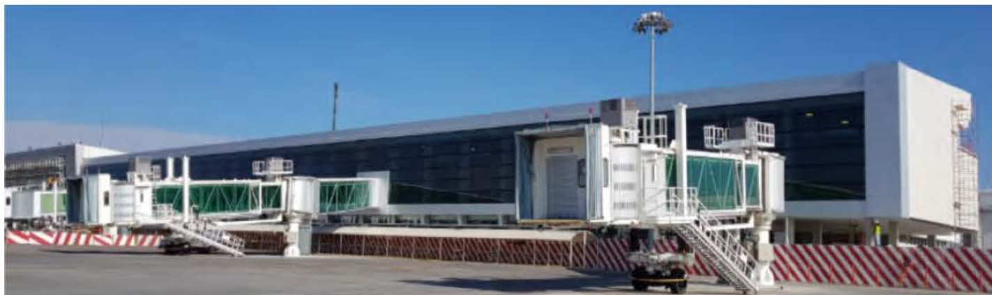
Ampliación de la Terminal 1, Aeropuerto de Guadalajara, Jalisco.
