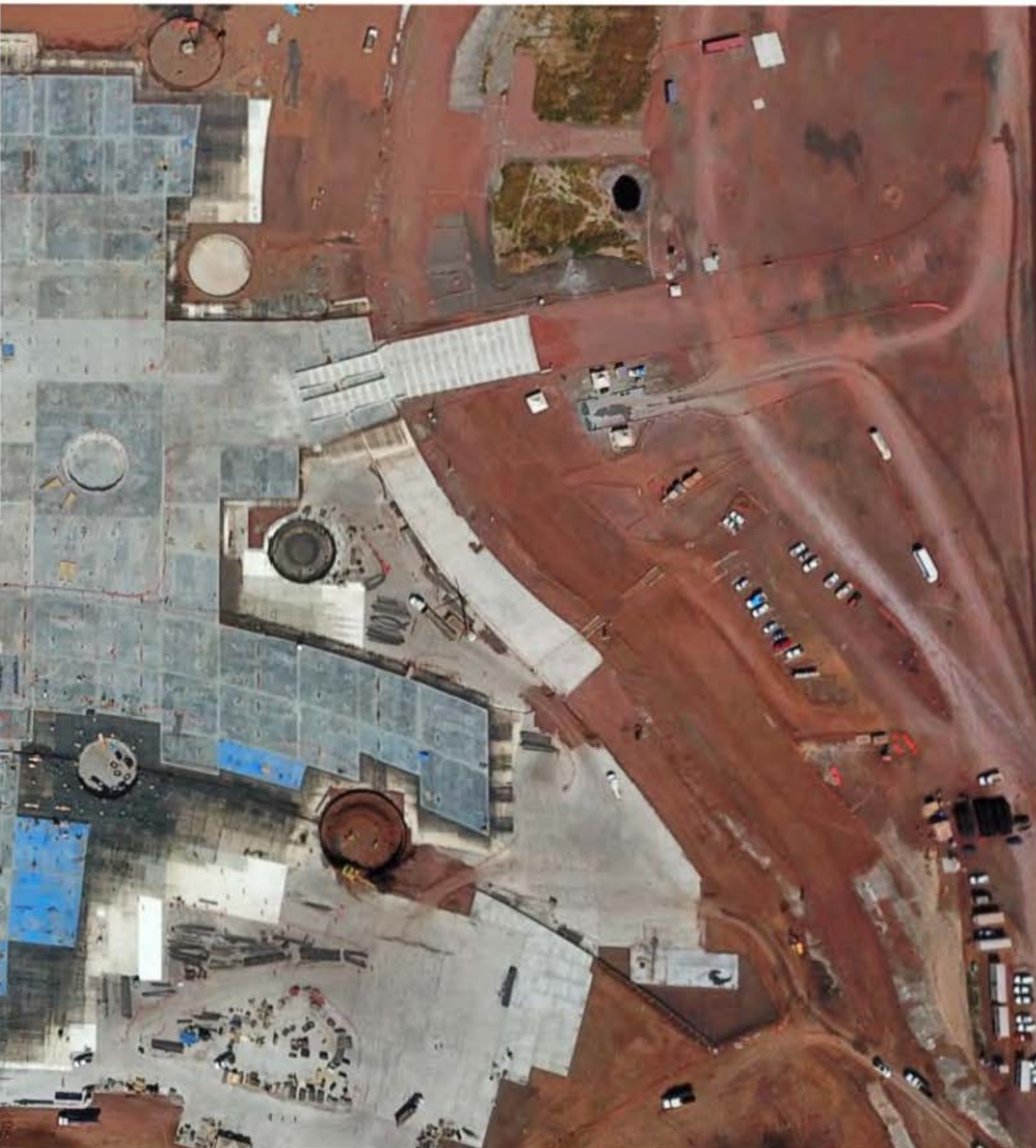
Avance de losa de cimentación del Edificio Terminal, NAIM.
