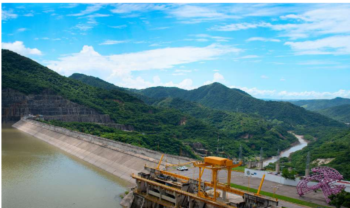
Central Hidroeléctrica Aguamilpa Solidaridad
