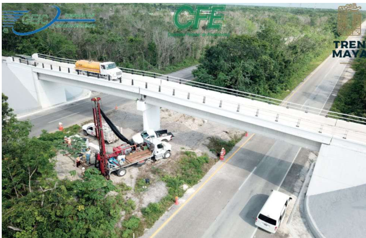
Ilustración 1 Sondeo de exploración geotécnica de la brigada de perforación
