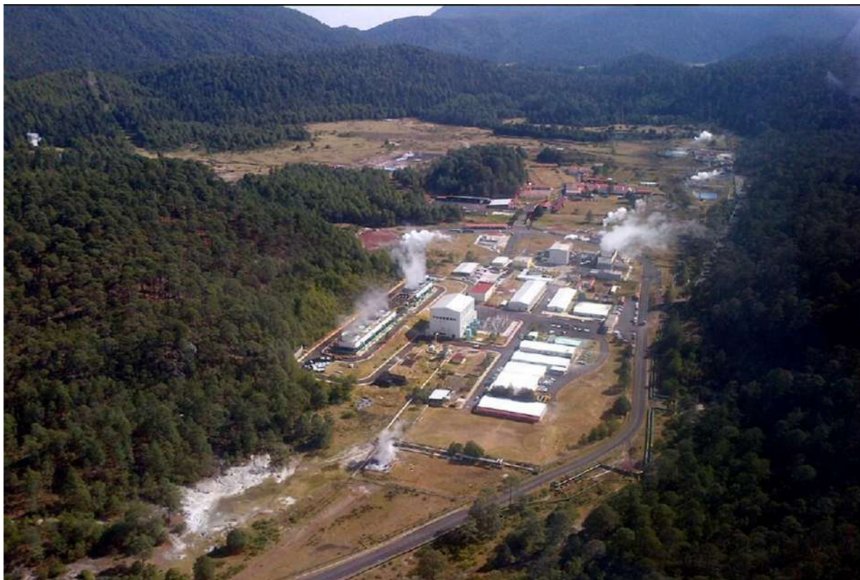
Central Geotermoelectrica Los Azufres
