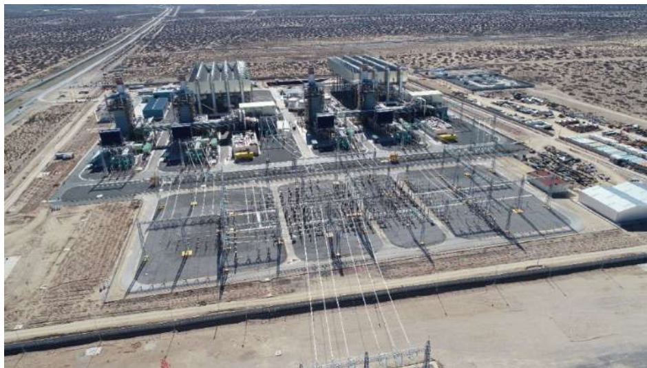
Fotografía: Panorámica del Proyecto CC Norte III
