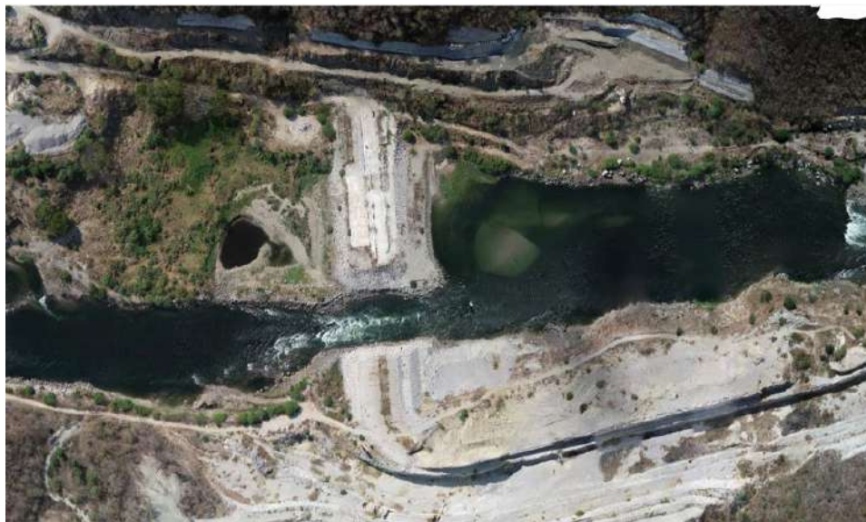
Fotografía: Avance de obra civil en el sitio del PH Chicoasén II, excavación en canal de desvío y atagüía aguas arriba.
