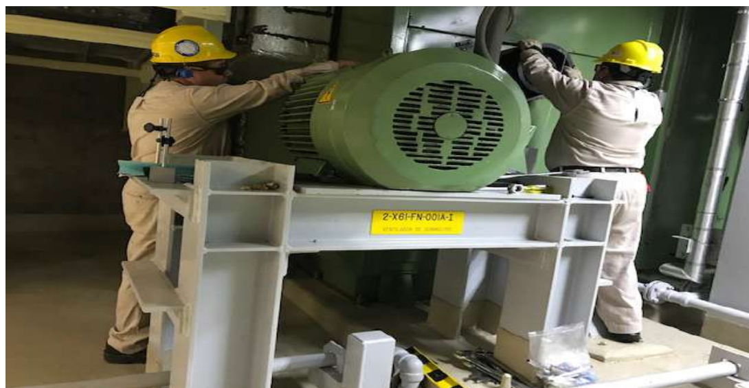
Trabajos en motor del ventilador del edificio de Control.
