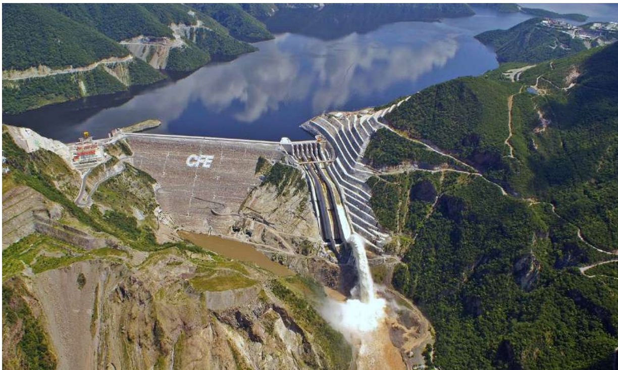
Central Hidroeléctrica Ing. Alfredo Elías Ayub (La Yesca)
