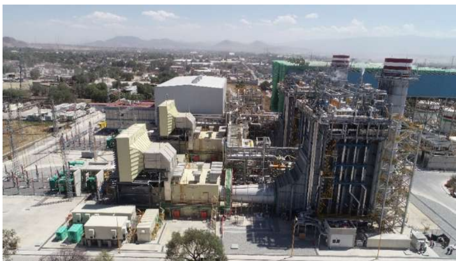
Fotografía: Panorámica del Proyecto CC Valle de México II
