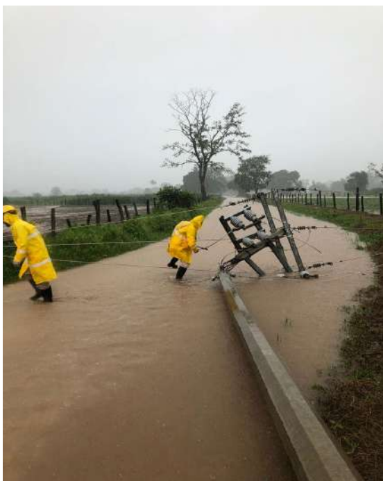
Personal realizando labores de reparación de las Redes Generales de Distribución
