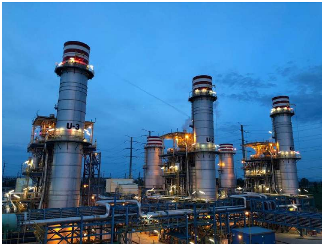
Central Cogeneración Salamanca
