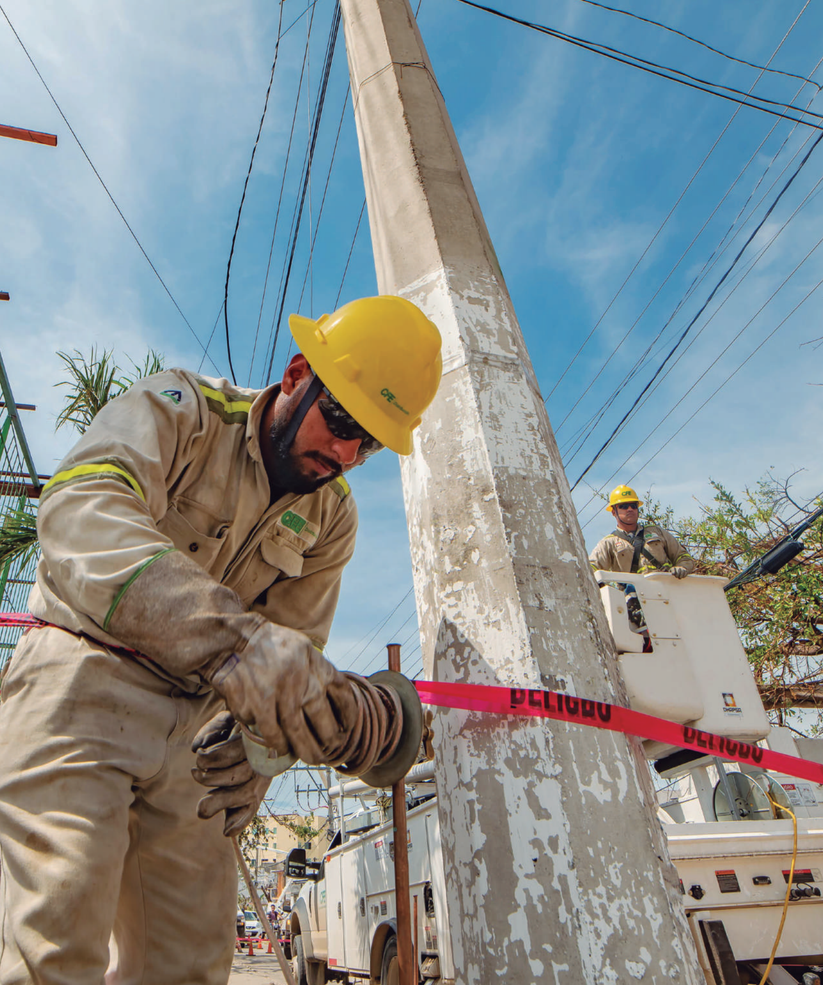
Fotografía 10. Restablecimiento de energía eléctrica, tras el paso del Huracán Otis. Acapulco, Guerrero. Comisión Federal de Electricidad.
