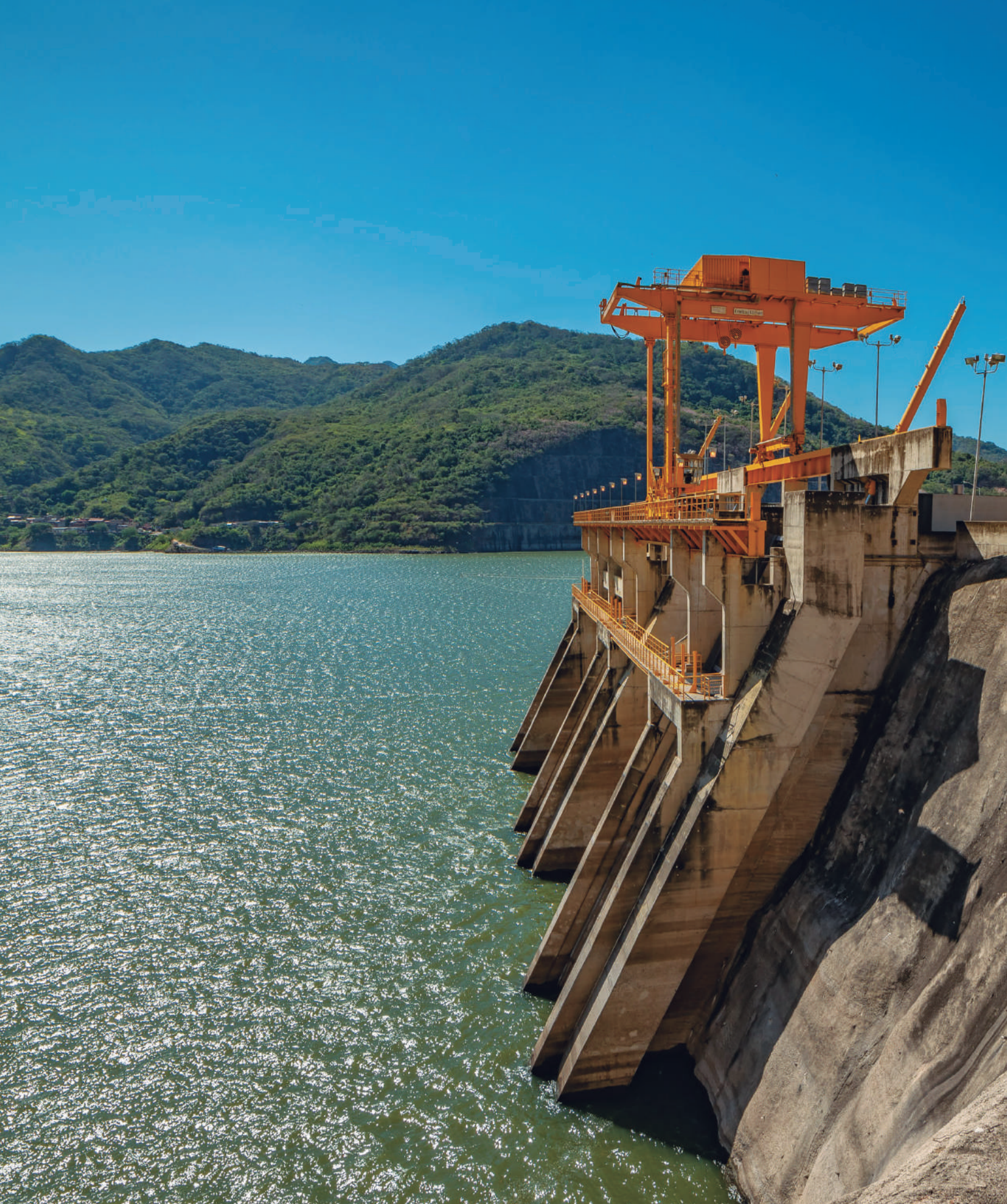
Fotografía 17. Central hidroeléctrica. Tepic, Nayarit. Comisión Federal de Electricidad.
