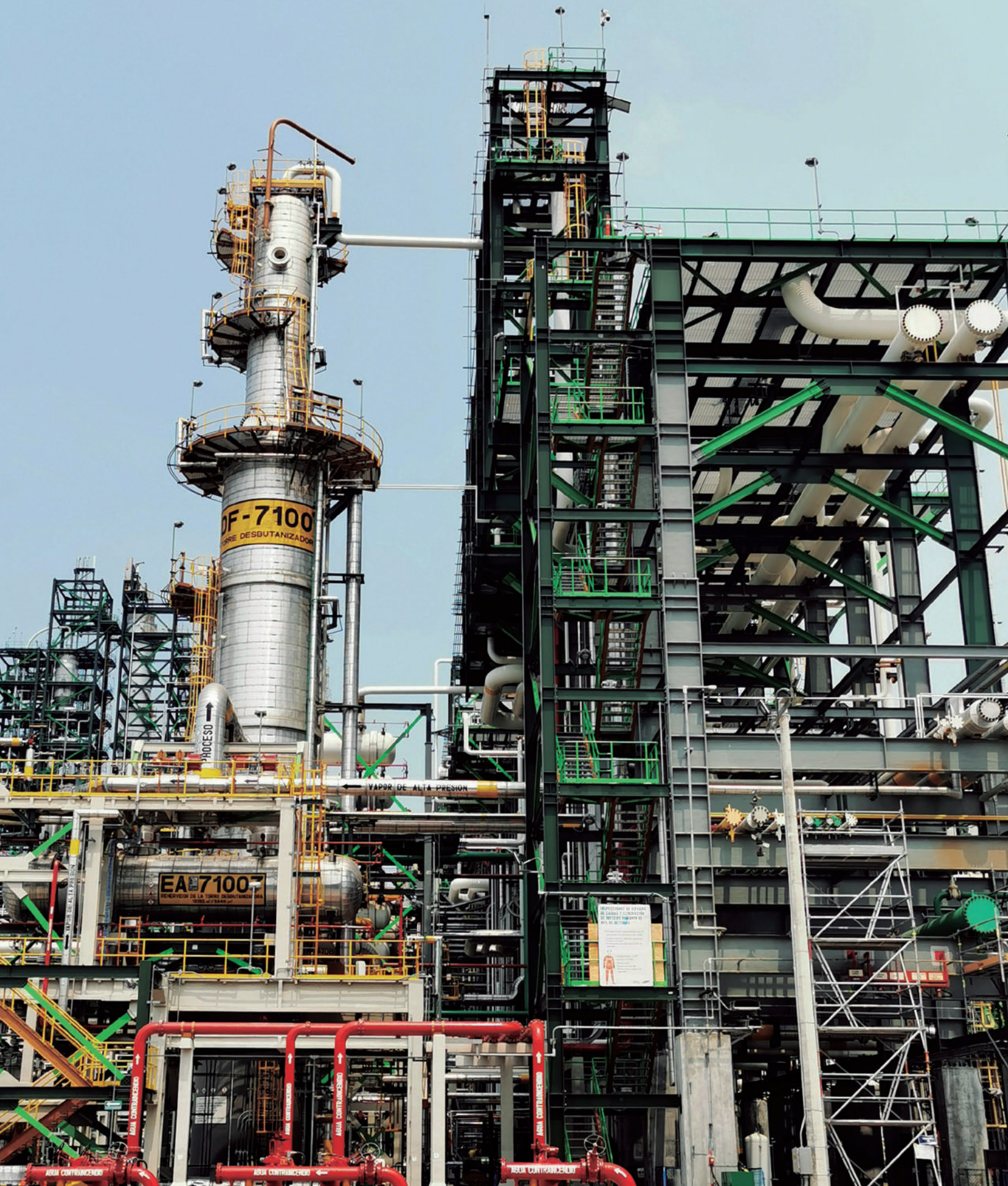
Fotografía 21. Refinería Olmeca en Dos Bocas, Paraíso, Tabasco. Secretaría de Energía.
