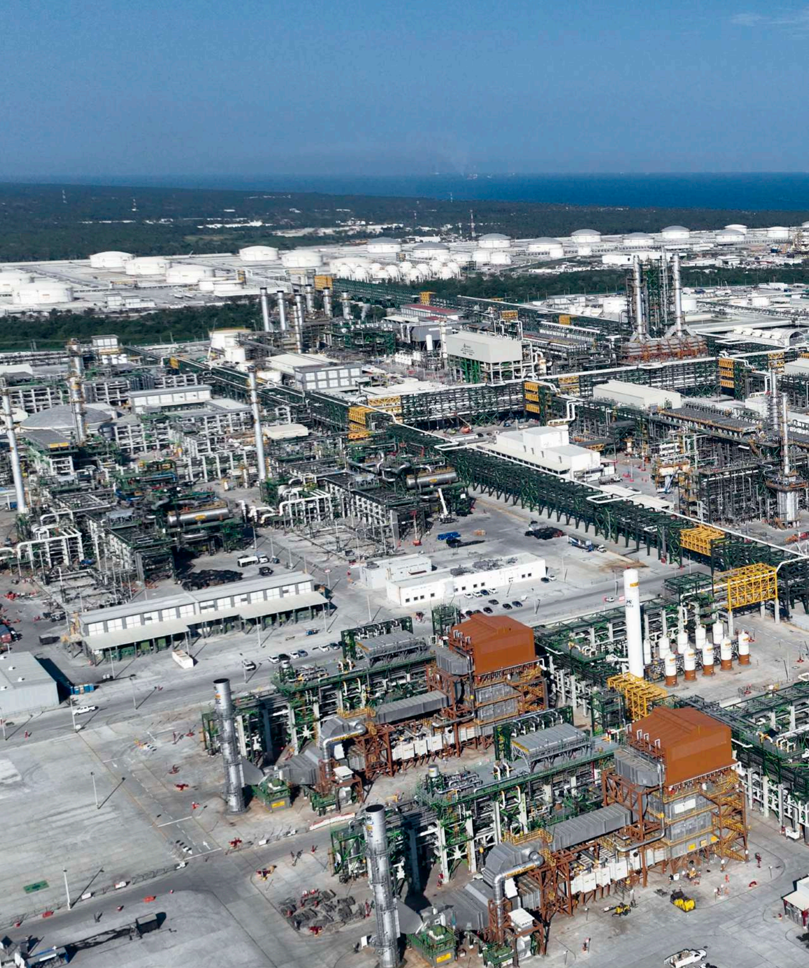
Fotografía 20. Refinería Olmeca en Dos Bocas, Paraíso, Tabasco. Secretaría de Energía.
