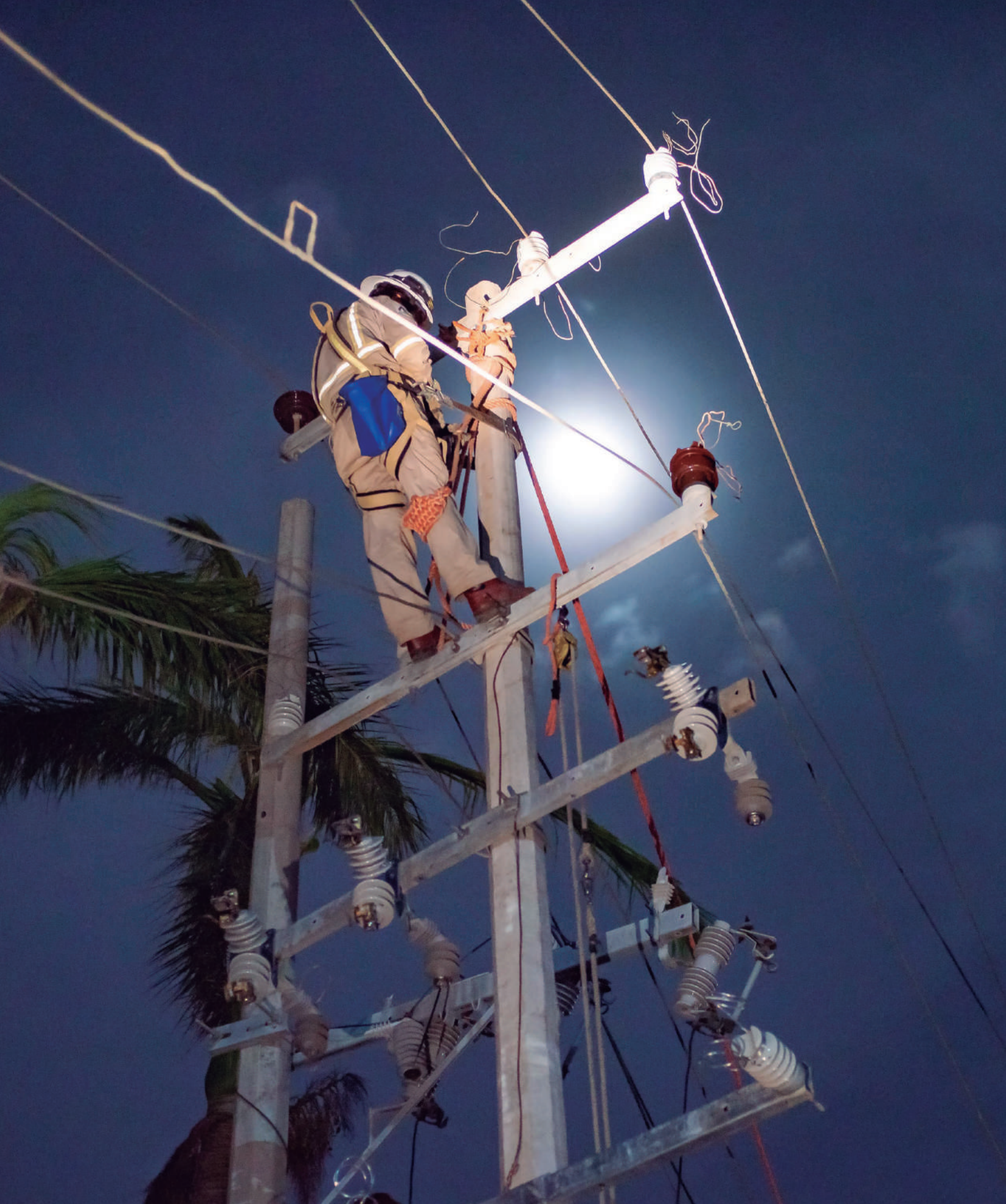
Fotografía 55. Restablecimiento de energía eléctrica. Acapulco, Guerrero. Comisión Federal de Electricidad.
