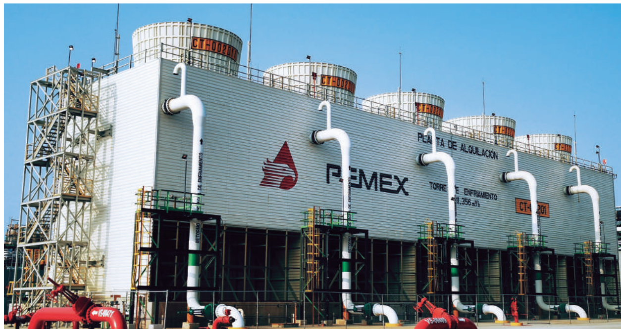
Fotografía 22. Refinería Olmeca en Dos Bocas, Paraíso, Tabasco. Secretaría de Energía.
