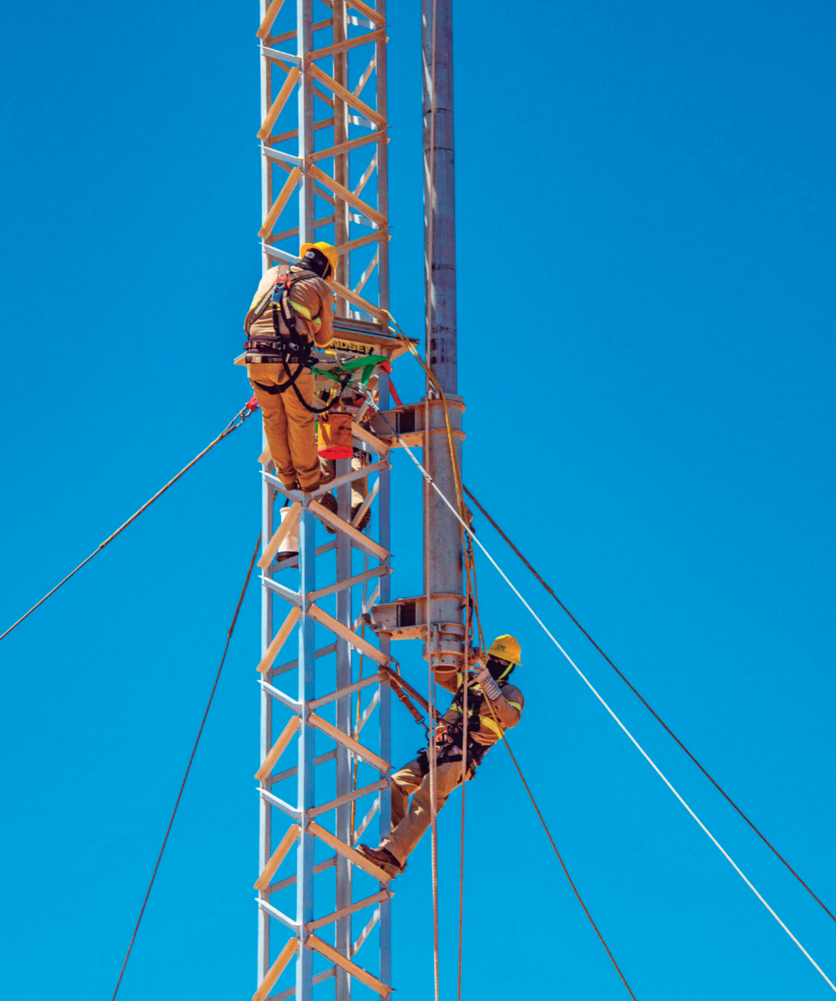
Fotografía 14. Maniobras de Reunión de Huracanes, 2024. Los Cabos, Baja California. Comisión Federal de Electricidad.
