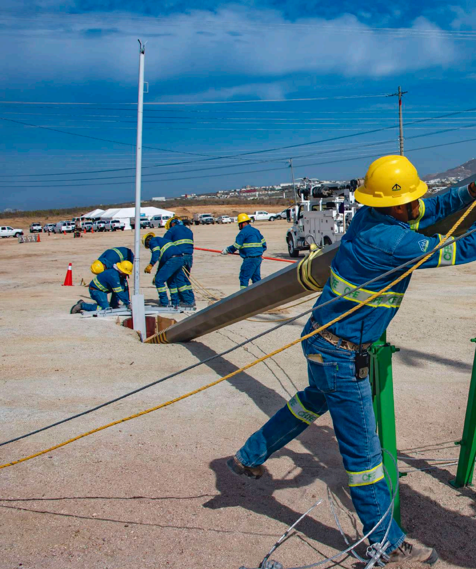
Fotografía 25. Maniobras de Reunión de Huracanes 2024. Los Cabos, Baja California. Comisión Federal de Electricidad.
