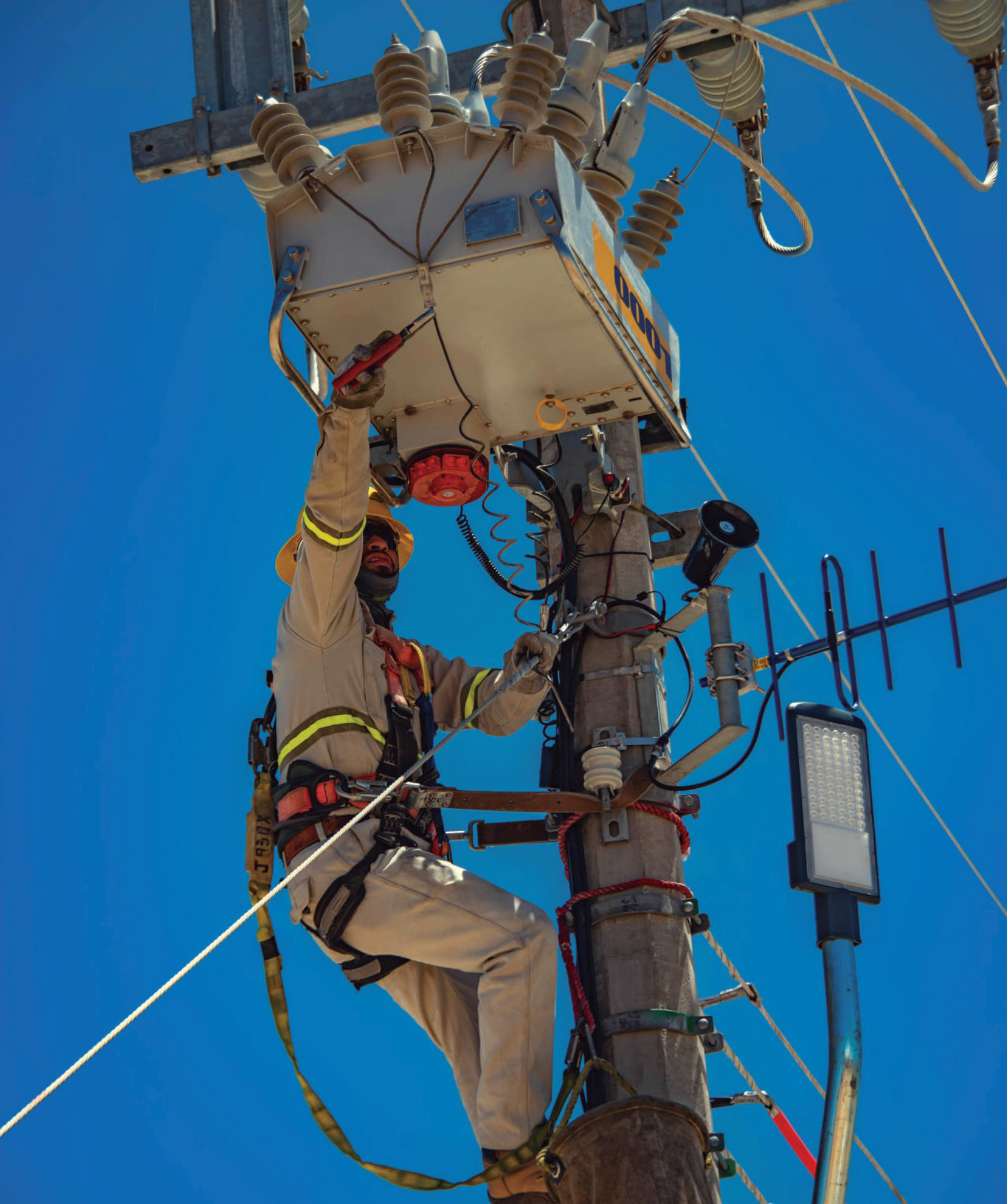
Fotografía 42. Maniobras de Reunión de Huracanes 2024. Los Cabos, Baja California. Comisión Federal de Electricidad.
