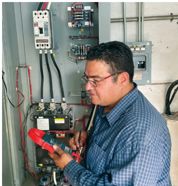
Fotografía 32. Visita técnica a pozo del sistema de aguas. Ciudad de México. Comisión Nacional para el Uso Eficiente de la Energía.
