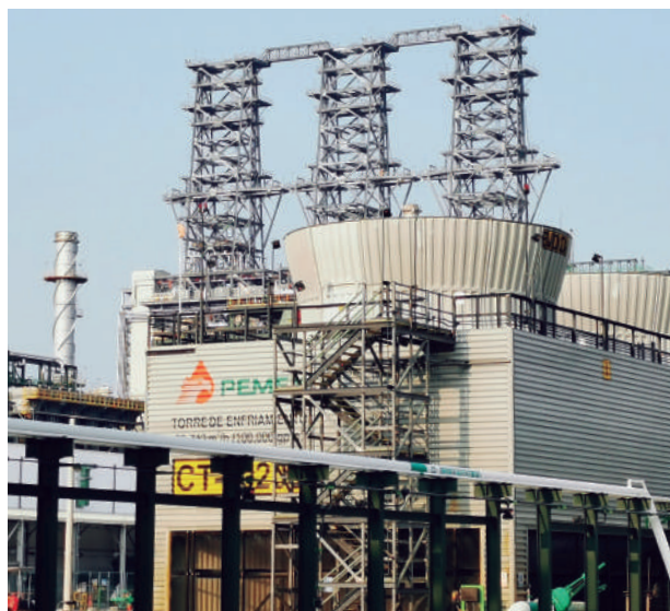
Fotografía 5. Refinería Olmeca en Dos Bocas, Paraíso, Tabasco. Secretaría de Energía.
