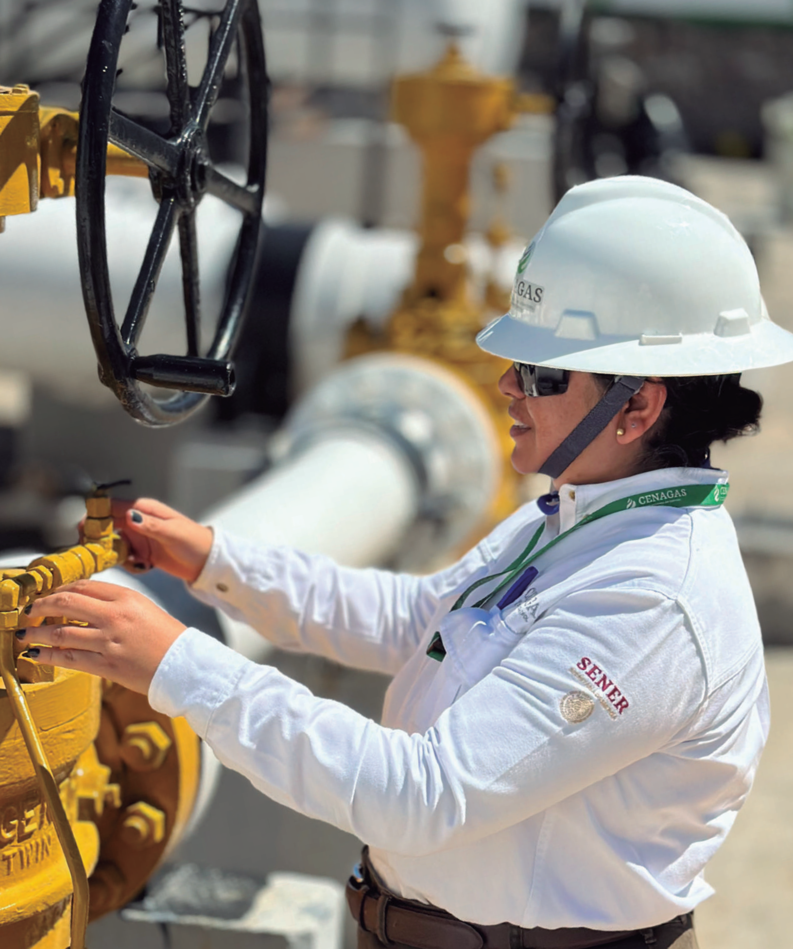
Fotografía 11. Sistema de filtrado GSD. Venta de Carpio, Jalisco. Comisión Federal de Electricidad.
