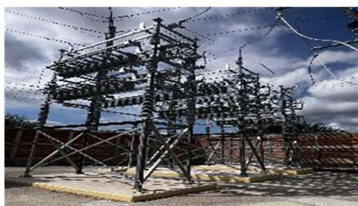
Ilustración 1. S. E. La Fragua (banco de capacitores)
