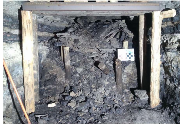
Fotografía: Rehabilitación del frente colapsado de la galería GSN6 Norte
