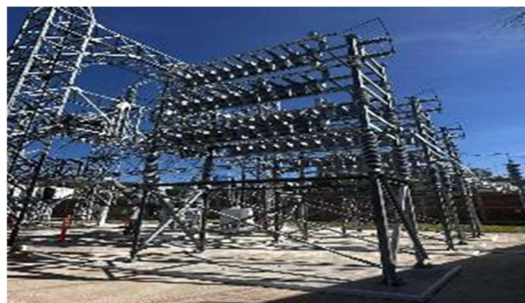
Ilustración 2. S. E. Querétaro (banco de capacitores)
